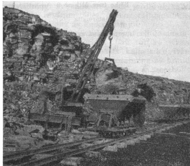
Fig. 8. Lastning av kalkstensblock med stenkran.
