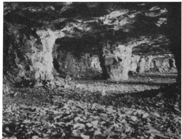
Fig. 4. Underjordiska rum, som utbrutits genom pelarbrytning (3,8 × 3,8 m pelare). Pelaravståndet är 6,0 m i brytningsriktning och 7,5 m vinkelrätt mot brytningsriktningen. Såsom sprängämne har använts bergkrut.
