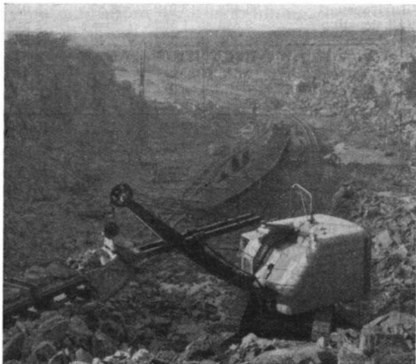
Fig. 7. Skifferlastning med grävmaskin.
