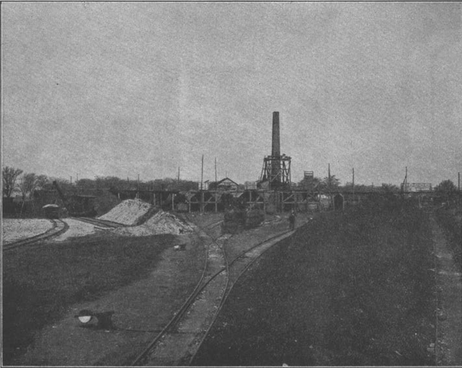
Lastningsmaskin jämte ler- och chamottebunkar vid Schakt Kung Oscar II.
