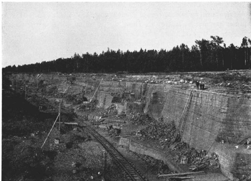
Fig. 45. Cementkalkstensbrottet vid Hällekis sett från söder. Väggarna utgöras av undre röd ortocerkalk (undre rödsten). A. H. Westergård 1919.
