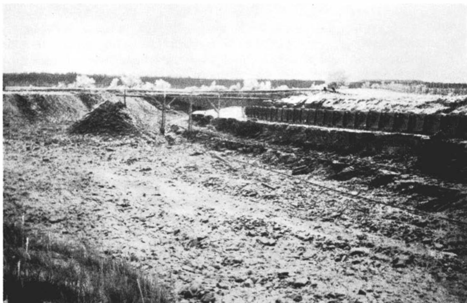
Fig. 73. Skifferbrottet vid Kinne-Kleva. Transport av skiffern.
