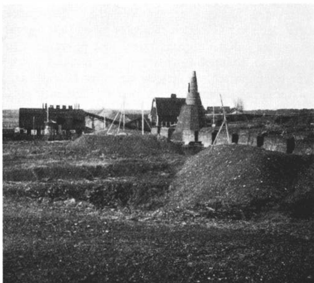
Fig. 74. Utsikt över skifferoljeanläggningen vid Kinne-Kleva. Till höger om schaktugnen äro fältugnarna för kalkbränning synliga. Bakom schaktugnen krossverk (till höger) och destillationsverk (till vänster). Bakom dessa asktippen.
