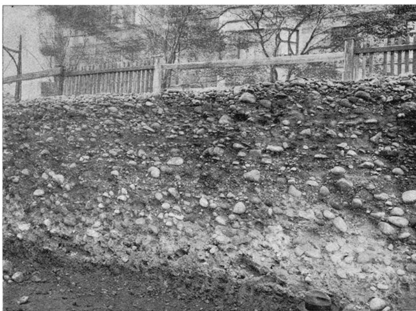
Fig. 13. Grundgrävning i hörnet av Drottninggatan och Margaretaplatsen. Allra nederst sandstensskiffer, där ovan strandgrus. Skärningen parallell med stranden. G. Troedsson foto sept. 1929.
