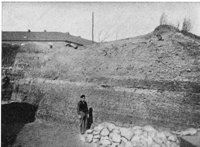
Fig. 14. Skärning vid Nytorgsgatan, mitt för Gustav Adolvsskolan. Typisk profil ovanför landavsatsten med hårt packad bottenmorän på rätisk sandsten. G.Troedsson foto mars 1930.
