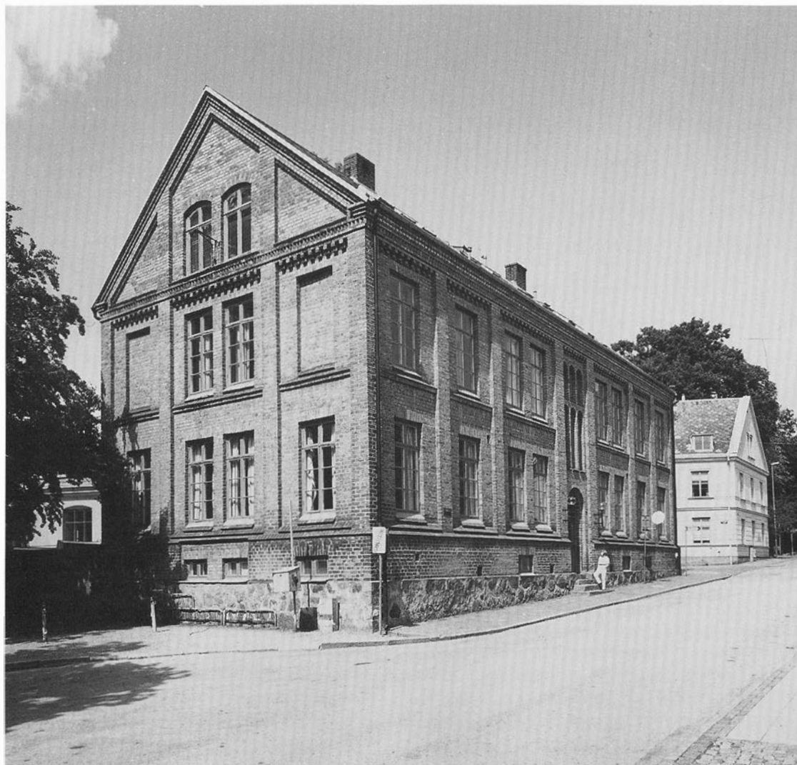
Huset på Sandgatan 1 blev den första egentliga Geologiska Institutionen i Lund, och verkade som sådan tills den nuvarande institutionsbyggnaden på Sölvegatan 13 blev byggd 1929-1930. Foto Sven Stridsberg.
