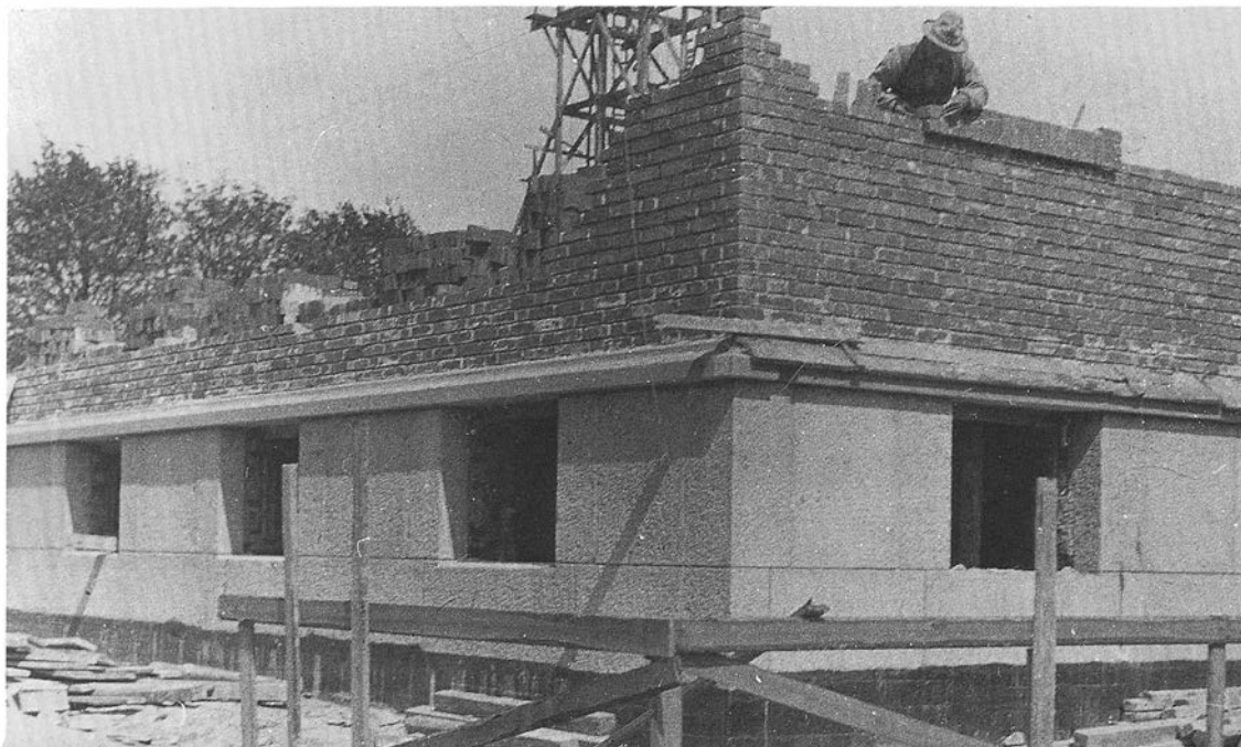
De första varven av murningen av det sydvästra hörnet på Sölvegatan 13 den 23 maj 1929. "Tornet" i bakgrunden är hisschaktet.
