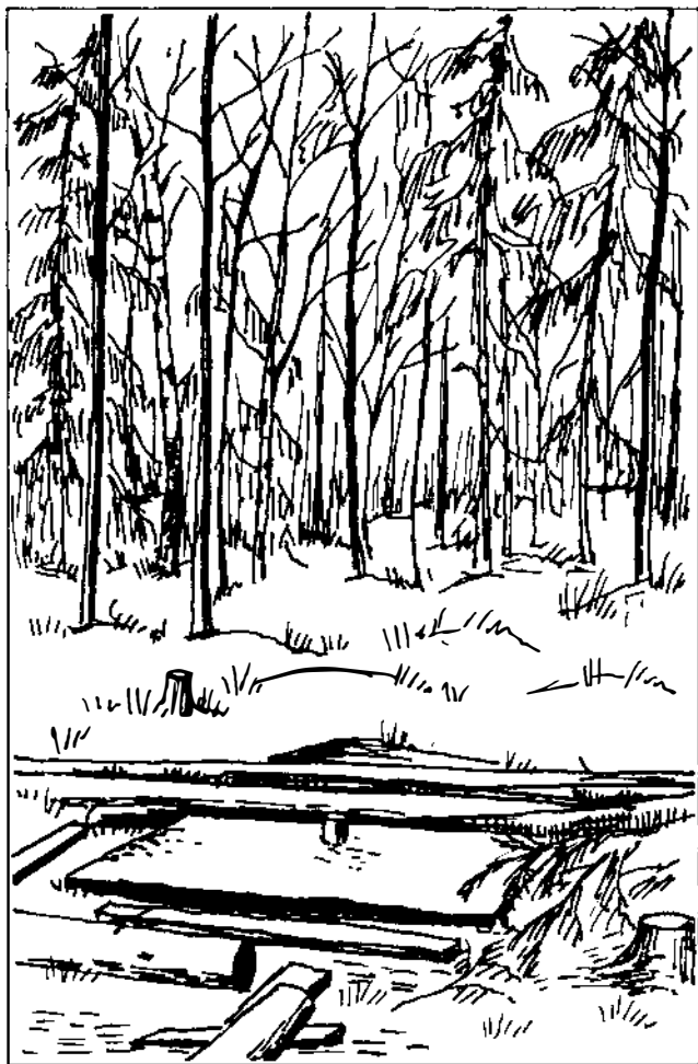
Borrhål 2 markeras av en cirka 2 kvadratmeter stor betongplatta med igensvetsat järnrör i en gles barrskog på torvjord. Teckning Tora Carserud.
